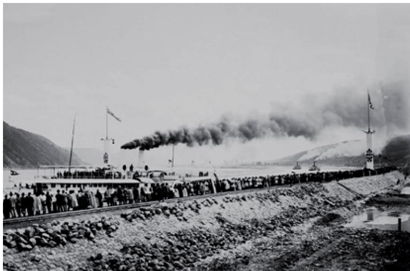
30. kép: Hutterer Géza: Vaskapu-csatorna megnyitása, a medercsatorna felhúása . 1896.
