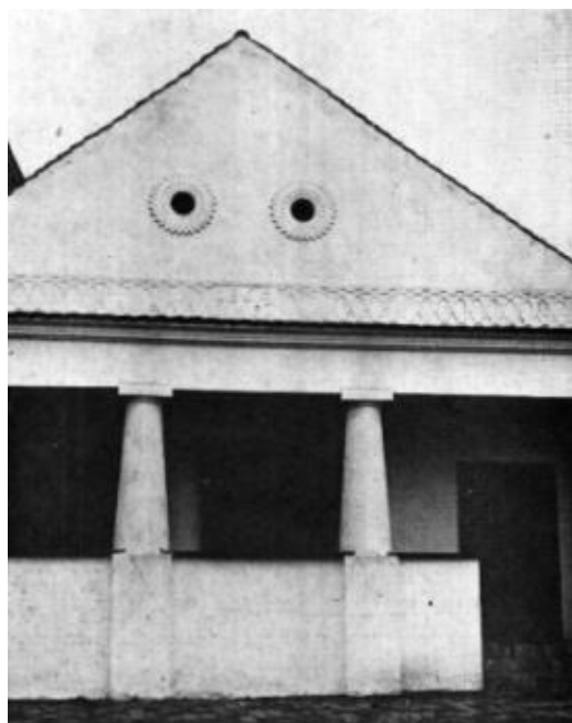
A ház helyreállítását követő homlokzati felvétel. Készítette: Sisa Béla. (Forrás: Sisa 1973: 174.)
