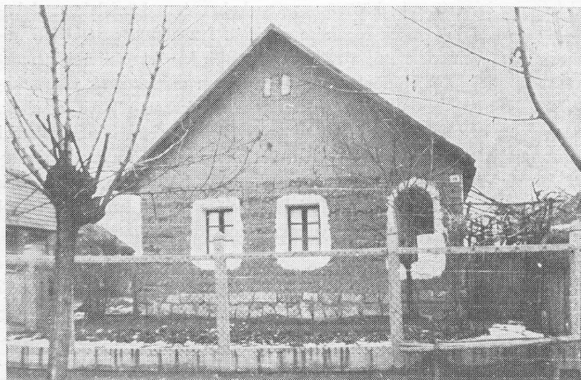
8. kép. Vertfalú lakóház homlokzata, Pócspetri
