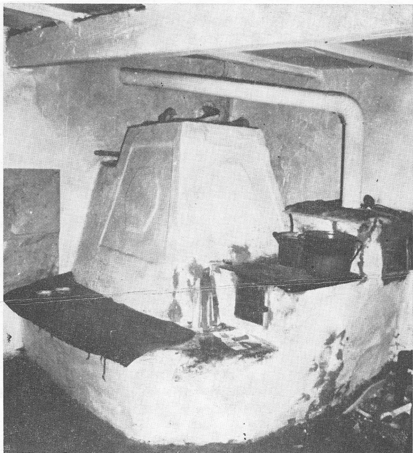
35. kép. Hasáb alakú kemence, padkájára épített masinával, Nyírszöllős
