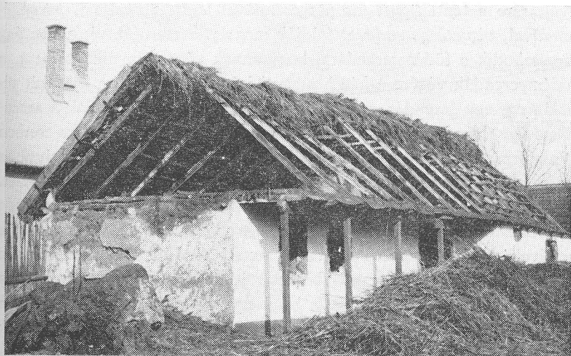
15. kép. Szarufás tetőszerkezetű ház bontás közben, Hajdúsámson
