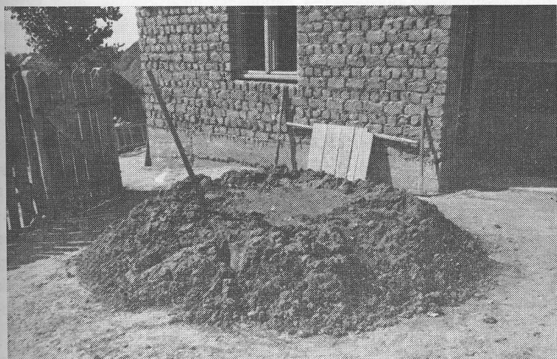
10. kép. Sárkészítés vályogfal tapasztásához, Nyíradony
