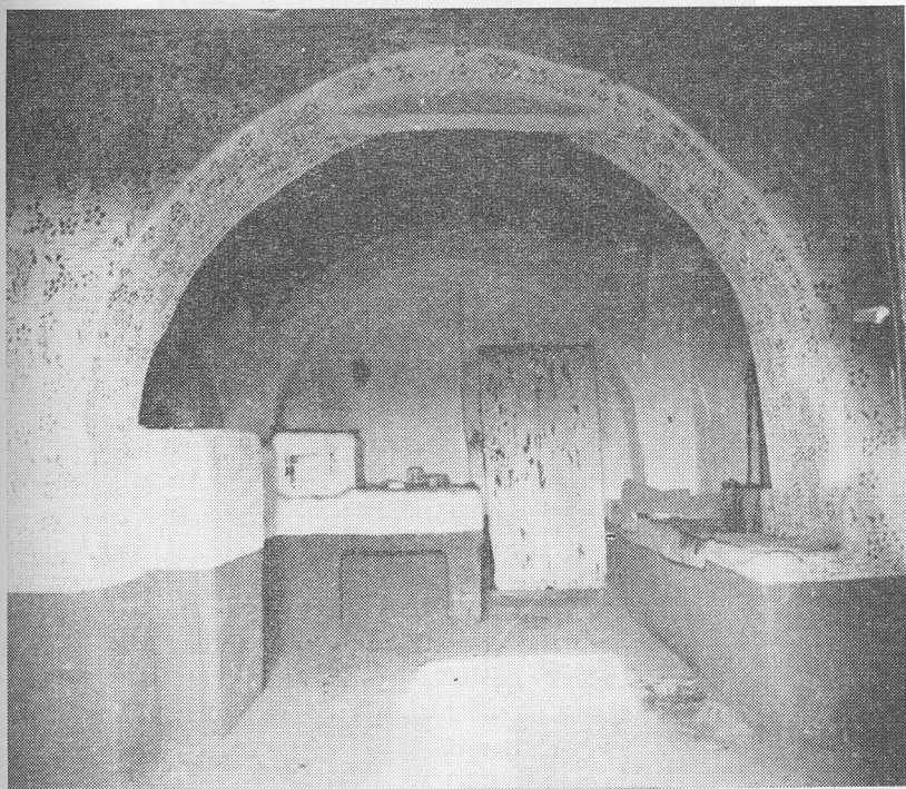
37. kép. Konyha tüzelőberendezése oldalpadkákkal és katlanokkal, Anarcs
