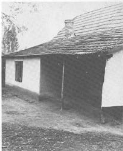
68. kép. Egyik végén beépített gang. Já- noshalma, Illancs. F: 35059.
