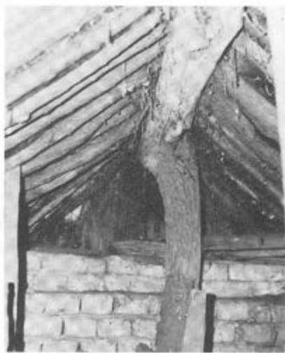
7. kép. Verem tetőszerkezete. Kiskunhalas, Eresztő. F: 46833.
