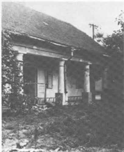
67. kép. Tornác. Szabadszállás, Szamuely u. 9. F: 38505.
