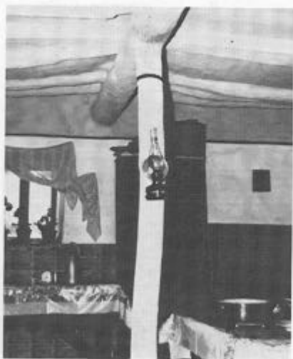
20. kép. Mestergerendás mennyezet, később beállított erősítő oszloppal. Kiskunmajsa, Maris puszta 111. F: 57168.
