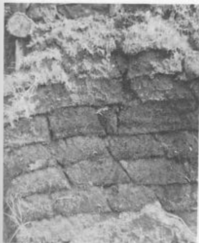
17. kép. Ferde oldalú hantokból rakott fal. Jánoshalma, Illancs
