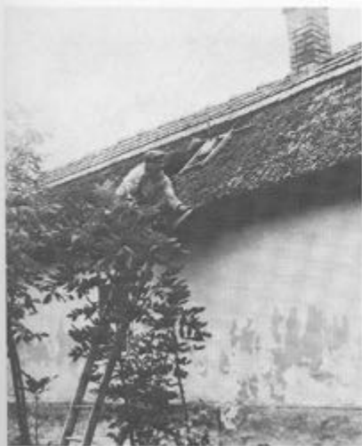
34. kép. Tető javítása, „duggatás”. Szabadszállás. F: 38259.
