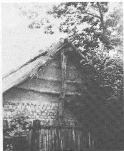
22. kép. Ágasos-szelemenés melléképület. Kunadacs, Alsó-Adacs 77. F: 38383.
