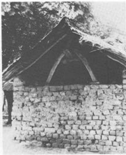
23. kép. Disznóól ollótalpas-szelemenés tetőszerkezettel. Kiskunmajsa. F: 48716.
