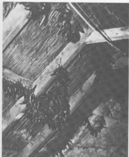
24. kép. Szarufás tetőszerkezet. Kunszentmiklós
