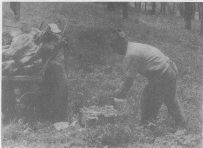
75. kép. A mészégető boglya tapasztása. Répáshuta. Petercsák T. felv., 1981
