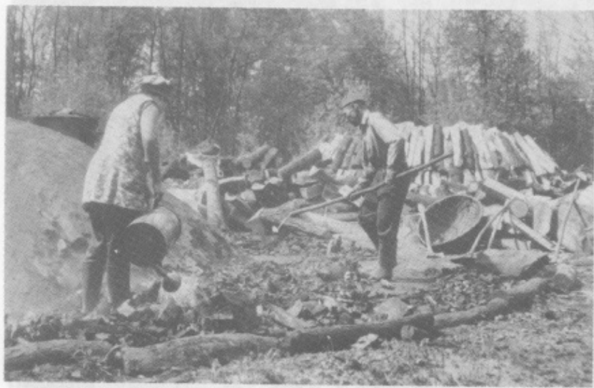
71. kép. A kiégett mîle szétbontása plészákkal. Mályinka. Petercsák T. felv., 1983
