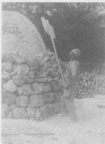
75. kép. A mészégető boglya tapasztása. Répáshuta. Petercsák T. felv., 1981
